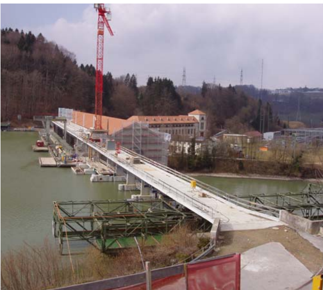
Mühlebergkraftwerk Erneuerung Stand März 2006
